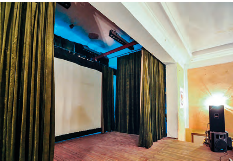
38. Rok 2015. Sala kina Orzeł tuż przed gruntownym remontem w latach 2016–2018
