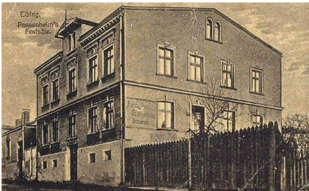
33. Budynek przy dzisiejszej ulicy Teatralnej zanim w okresie 20-lecia międzywojennego otwarte zostało w nim kino
