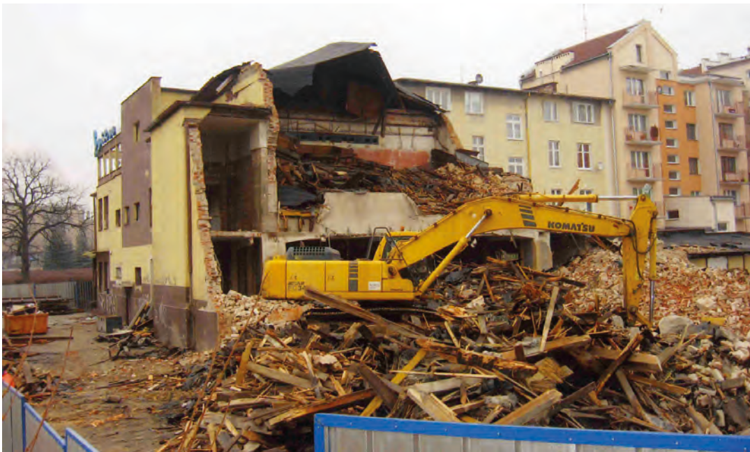
132. Rozbiórka budynku po kinie Syrena. W głębi widoczny kulturowy neon, który obecnie znajduje się w Muzeum Neonów w Warszawie
