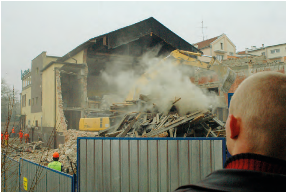
134. W piątek 18 stycznia 2008 roku rozpoczęła się rozbiórka kina Syrena
