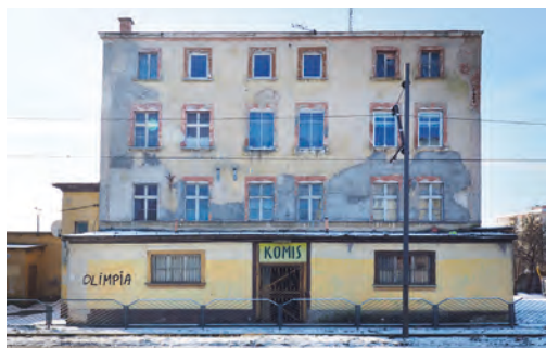
48. Kino Kolarz mieściło się w wybudowanym w 1908 roku budynku przy alei Grunwaldzkiej 20
