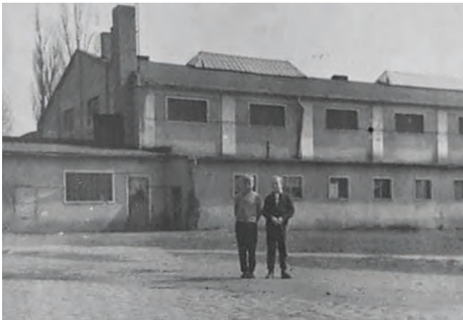
40. Na drugim planie kino Zamech i hala widowiskowa od strony zaplecza
