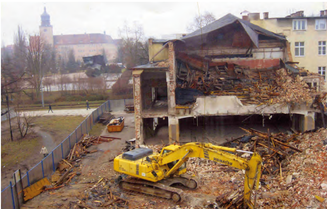
133. Widok na trwającą rozbiórkę budynku od strony ulicy Michała Bałuckiego
