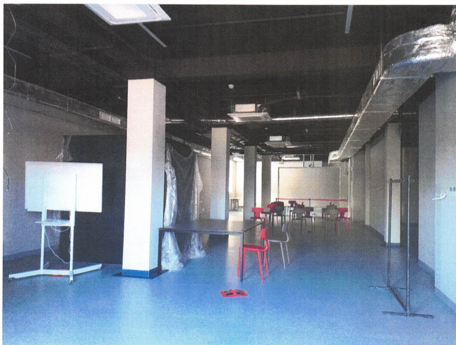
Fot. 1 widok na część A i B
