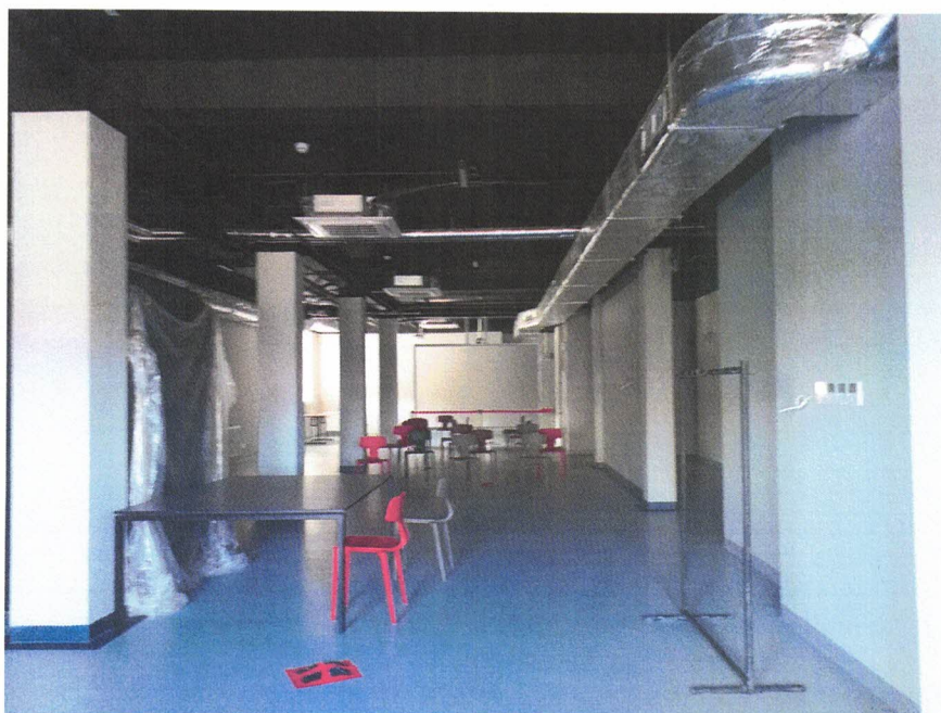
Fot. 2 Widok na część A
